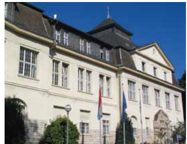
Verwaltungsgebäude der Hütte, Esch-sur-Alzette
