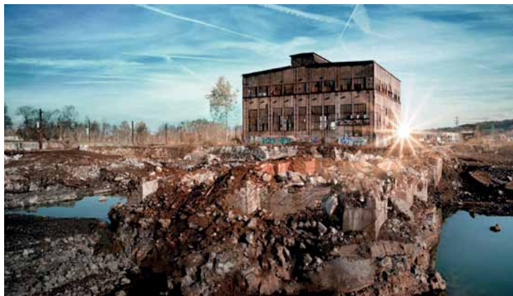
Alte Gebläsehalle im Viertel Rout Lëns
