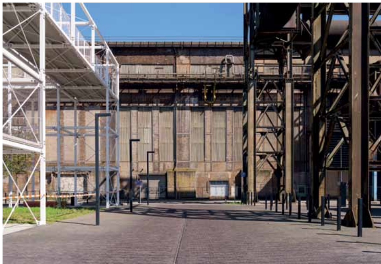
Die Hütte Esch/Belval in Betrieb
