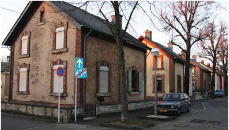
Arbeiterhaus im Viertel Hiehl, Esch-sur-Alzette
