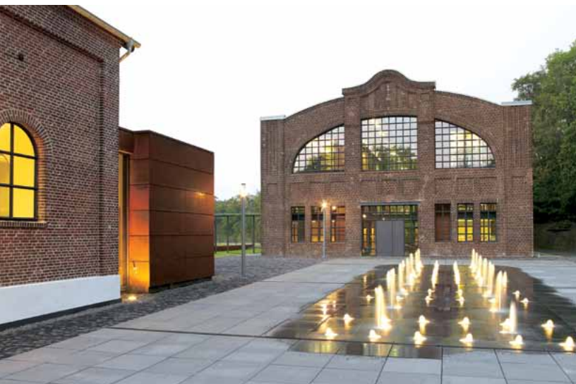
Ehemalige Gasturbinehalle der Hütte ARBED Esch-Schiffange
